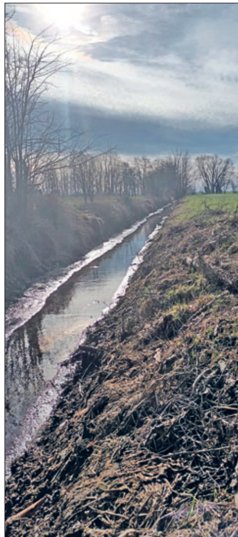
Zulauf Löschwasserentnahmestelle Adelsdorf
